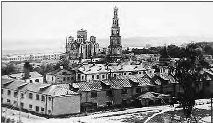
Коммуна № 2 ОГПУ и.м. Дзержинского
